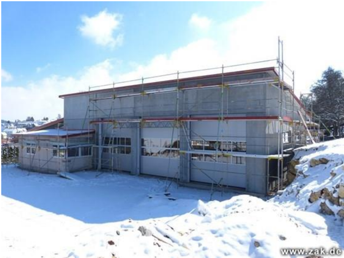
Der Bau der neuen Fahrzeughalle für die Oberheimer Feuerwehr geht voran. Foto: Volkmar Hoffmann
